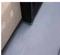
①旧FRP防水面清掃
