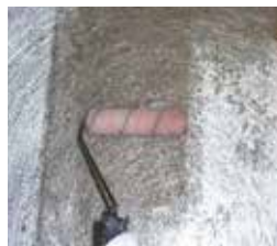
②ノンスチ樹脂・ガラスマット積層
