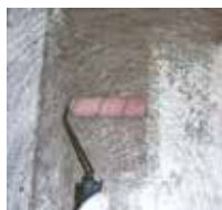
②ノンスチ樹脂・ ガラスマット積層
