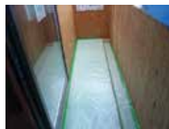
②勾配付き断熱材敷き込み
