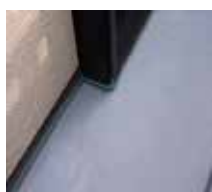
①旧FRP防水面清掃
